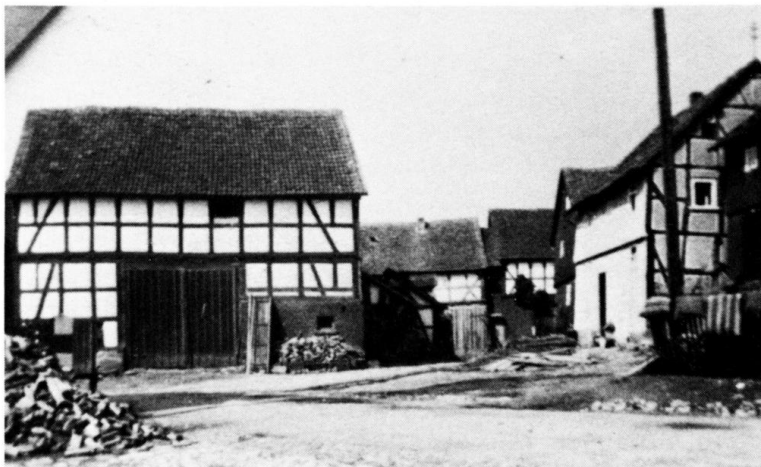
Blick von der Burgasse in den Bogenweg.
