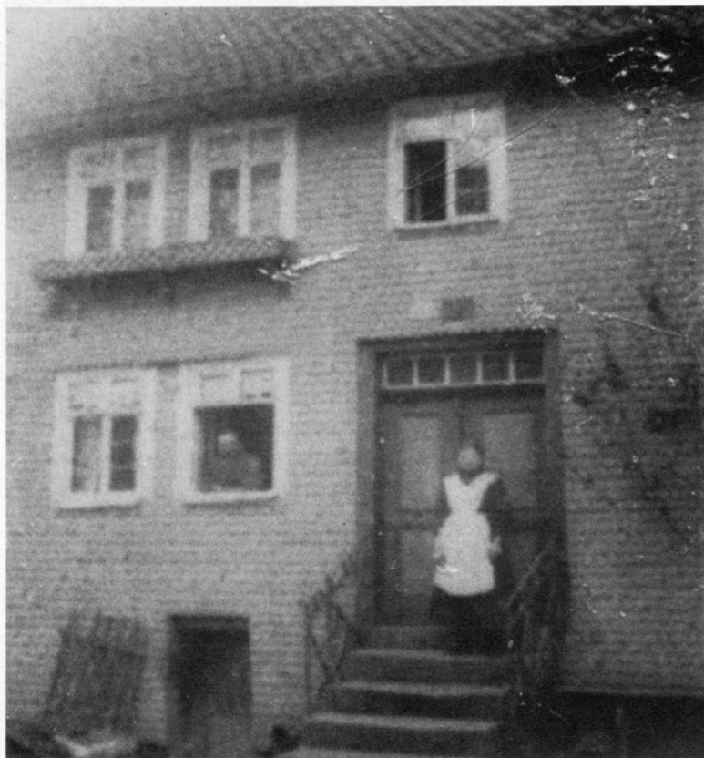
Ebelshaus am Kirchberg wurde 1960 abgebrochen.
