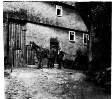
Einfahrt zum alten Ebelhof an der Hauptstraße (abgebrochen in den 30er Jahren). Er war zwischen Weberhaus und Hannpetershaus.
