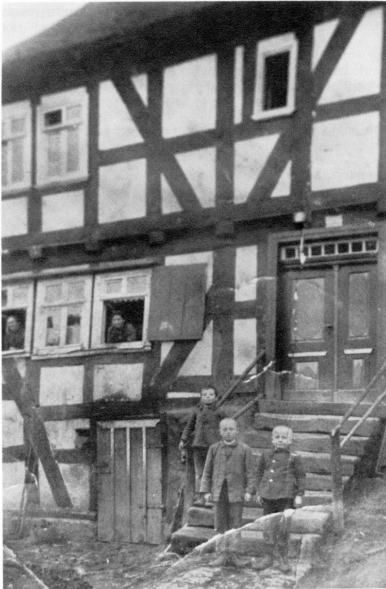
Neklosehaus (linker Teil vom Blasehaus).
