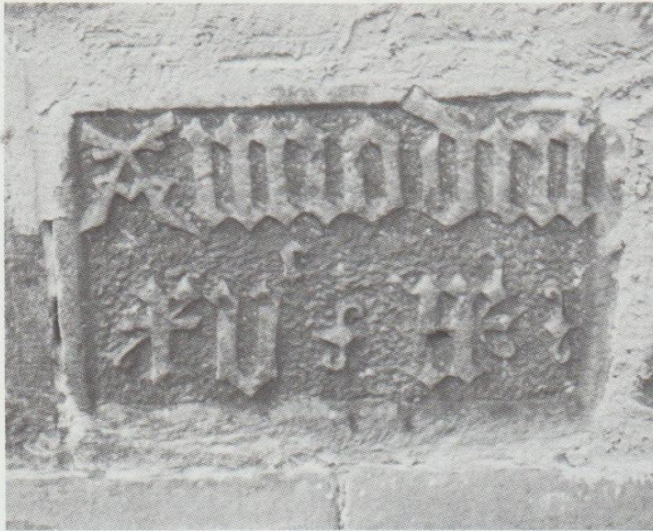
Den Grundstein der alten Kirche aus 1509 legte Dekan Müller aus Amöneburg am 15. September 1867 für die neue Kirche
