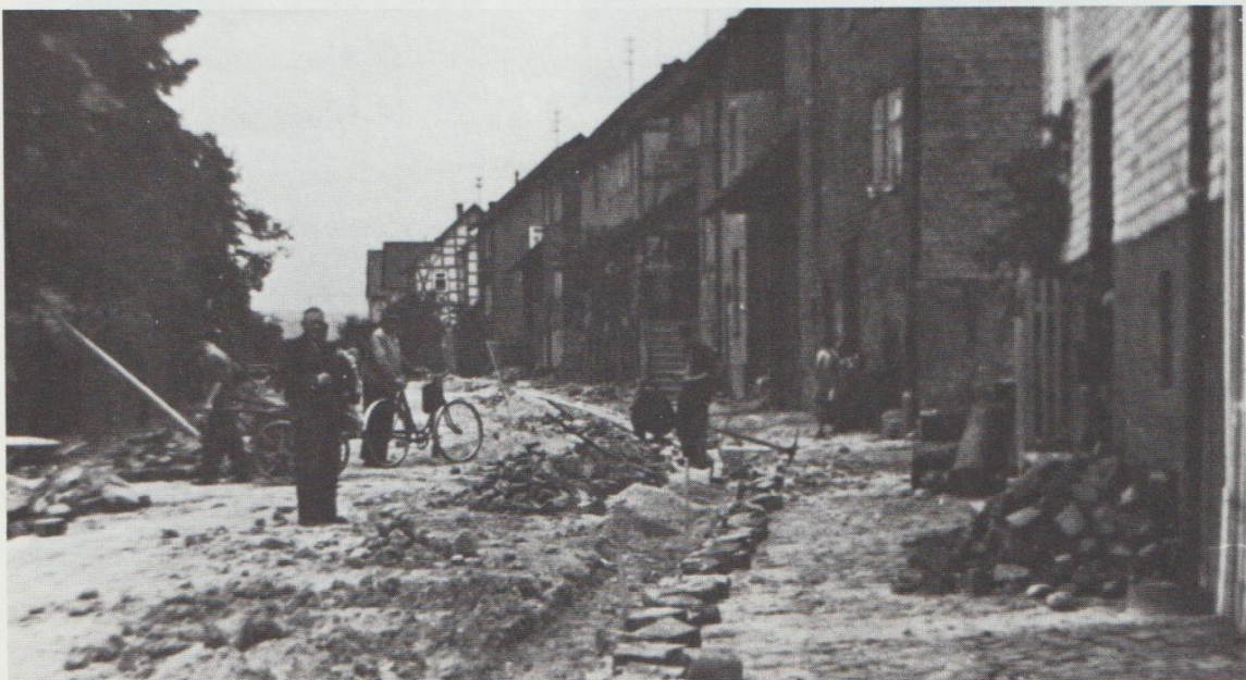
Beim Ausbau der Neuen Straße
