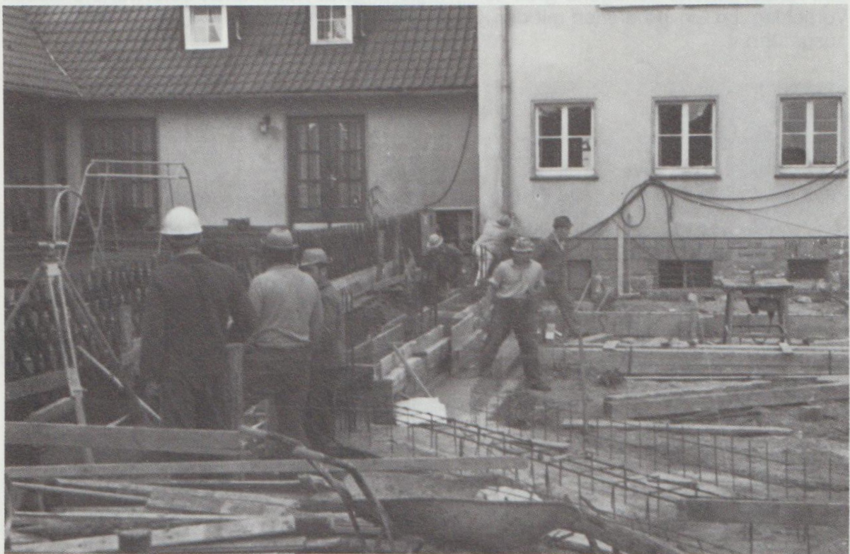
Bauarbeiten für den Anbau
