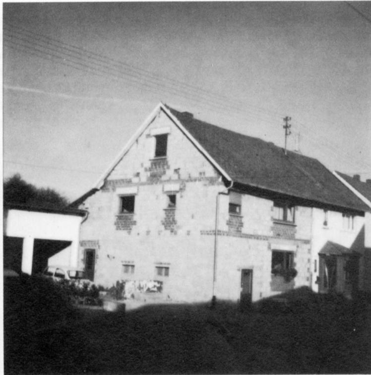
Das Austinshaus in der Wieraer Straße. (Erbaut 1805) Umbau der Scheune zum Wohnhaus 1979
