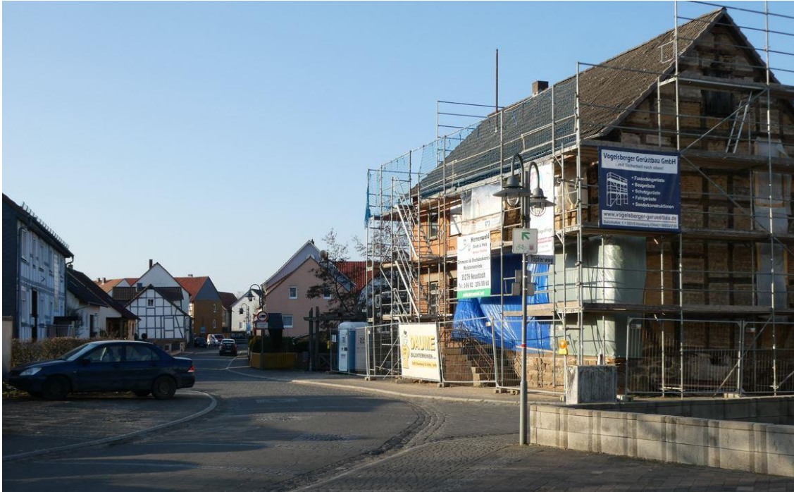
Und der Blick in die andere Richtung: Ansicht der Ecke Ringstr.-Töpferweg
